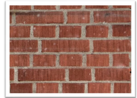
Tiilimuuraus (tiili + muuraus)
