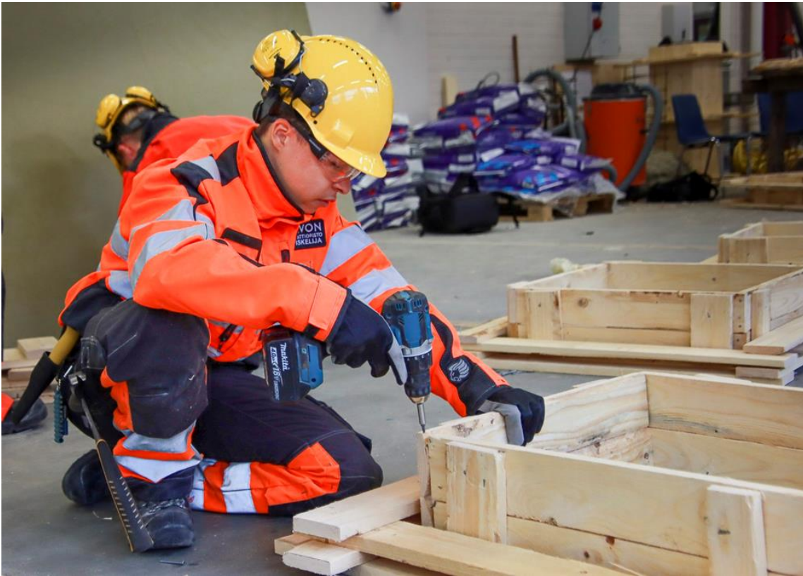
Kuva 12. Rakentamisan opinnottajat alkavat sokkelin teosta.
